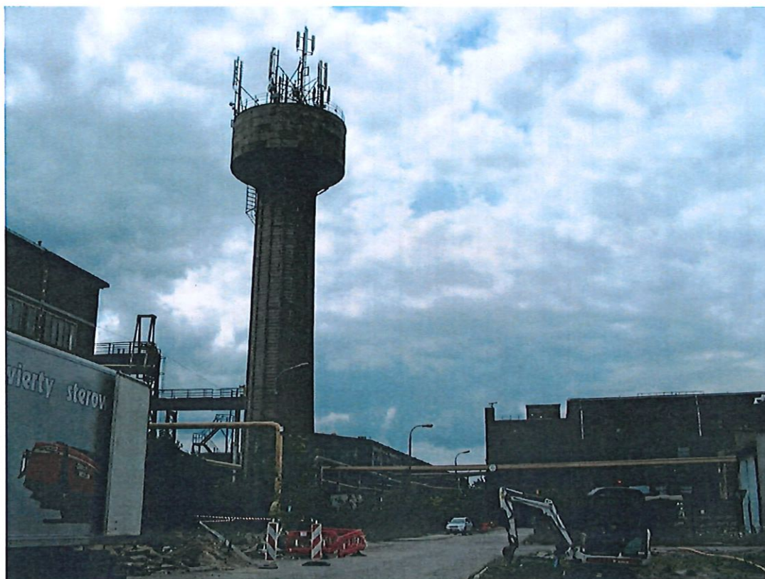
Fot. 1. Wieża ciśień - BT22486_STALOWA WOLA_HUTA - widok
