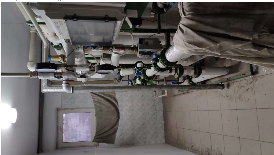
Węzeł centralnego ogrzewania
