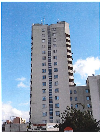
Widok obiektu wraz z zainstalowanym zespołem antenowym
