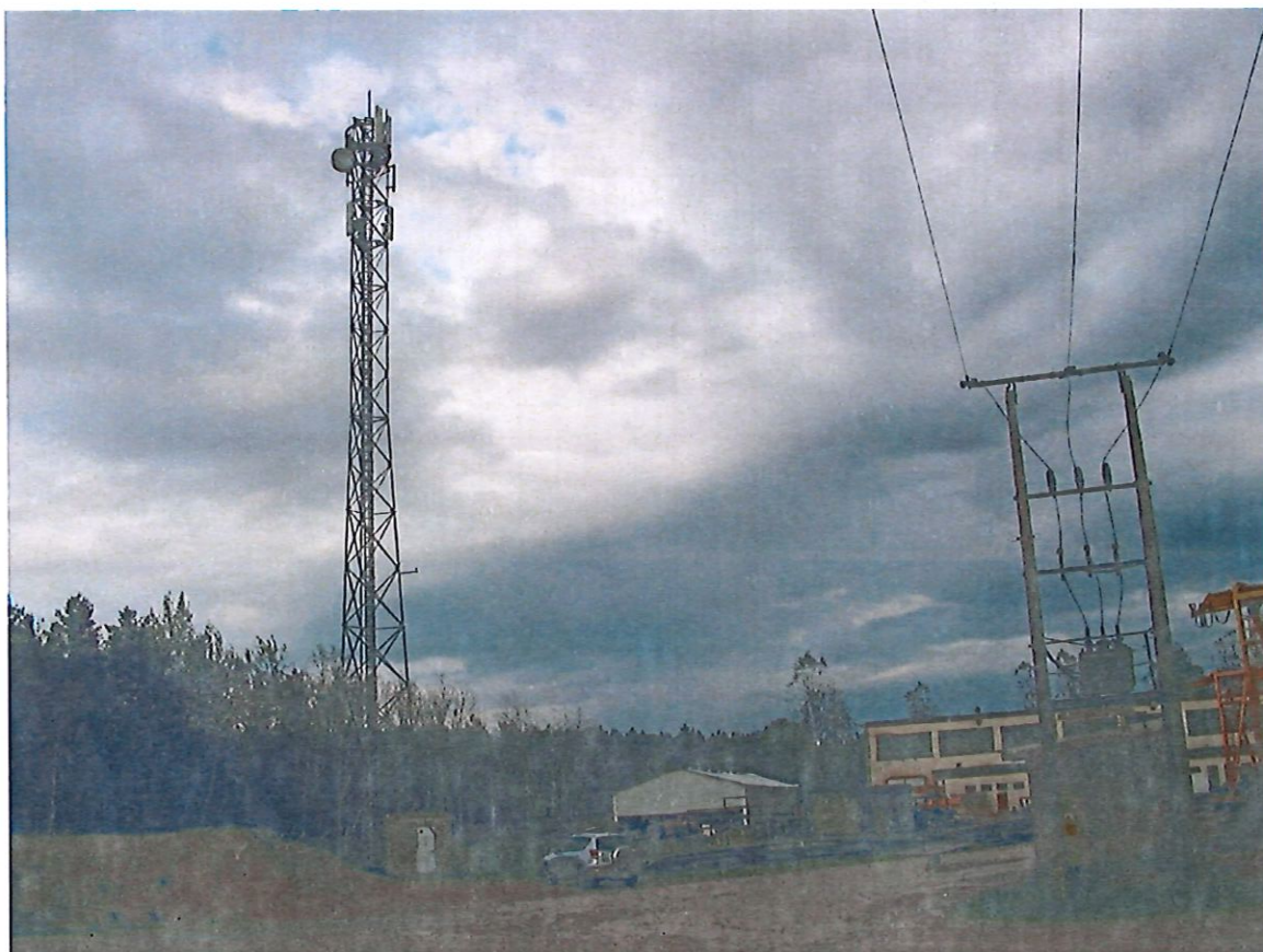
Fot. 1. BT_22908_STARA_LIPA – widok wieży antenowej
