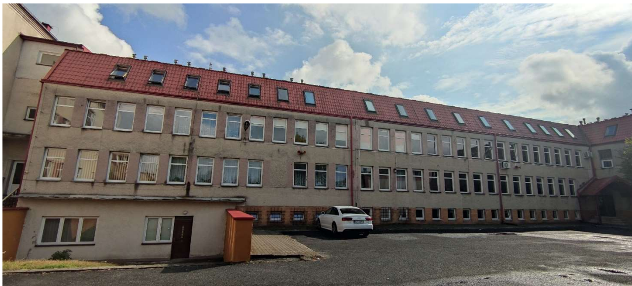
Elewacja tylna segment A
