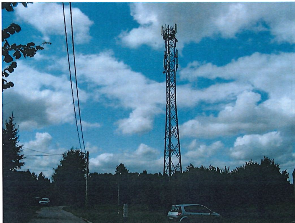
Fot. 1. Stacja bazowa telefonii komórkowej sieci TOWERLINK BT_22326_SPOKOJNA - widok obiektu
