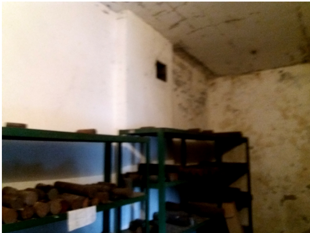
Zdjęcie nr 5: Budynek garażowo-magazynowy, pomieszczenie magazynowe, widoczna konstrukcja ścian i stropodachu z płyt kanałowych
