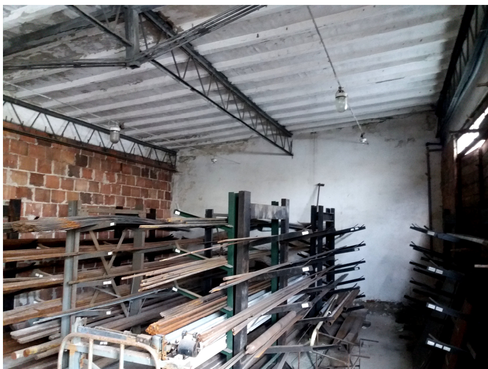
Zdjęcie nr 4: Budynek garażowo-magazynowy, pomieszczenie magazynowe, widoczna konstrukcja ścian i stropodachu z płyt korytkowych
